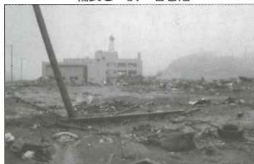
4月23日 街全体が津波で壊滅した感があまる南三陸町
